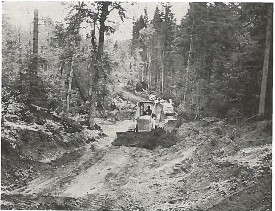
Bulldozing a logging road, Pittsburg, N. H. Courtesy U. of N. H.
